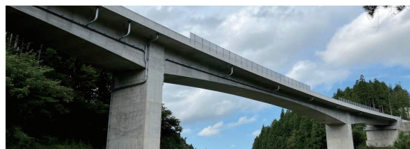
一般国道470号 能越自動車道 輪島道路
